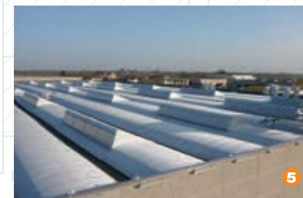
Copertura metallica sistema macroshed
