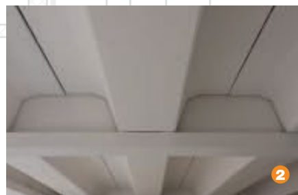
Solaio Syntesi - vista da sotto
