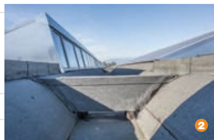
Trave sovrapporgente - rivestimento in guaina
