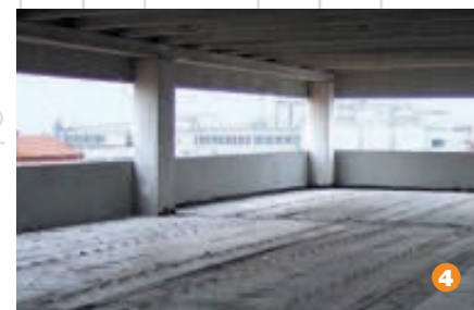
Solaio a TT - vista da sopra prima della realizzazione della cappa collaborante
