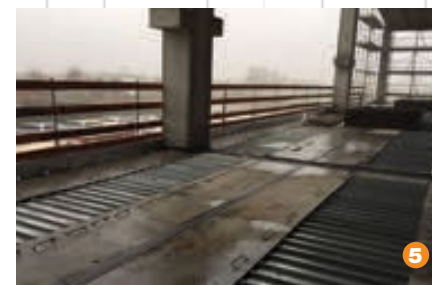
Solaio Syntesi - vista da sopra prima della realizzazione della cappa collaborante
