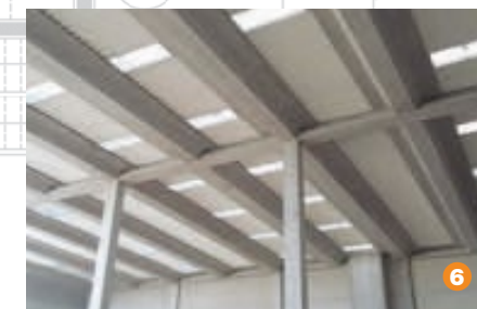
Copertura con Syntesi e lamiera continua
