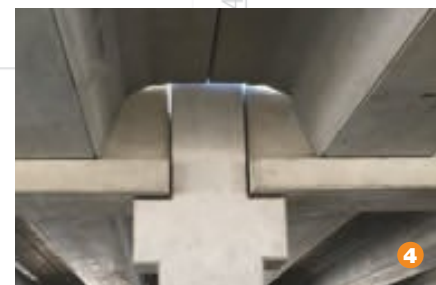
Nodo pilastro/trave/Syntesi
