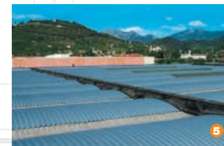
Copertura in lamiera zincata preverniciata/aluzink
