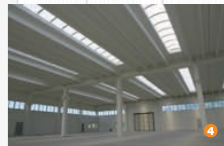
Lucernario zenitale con profili di irrigidimento
