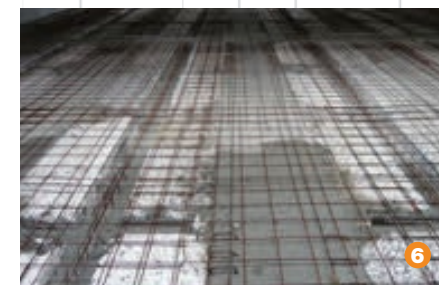
Solaio Slim - vista da sopra prima della realizzazione della cappa collaborante
