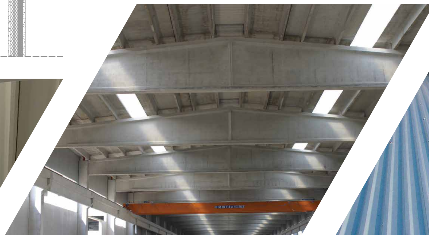
SOLUZIONE CON ARCARECCI E PANNELLO SANDWICH
